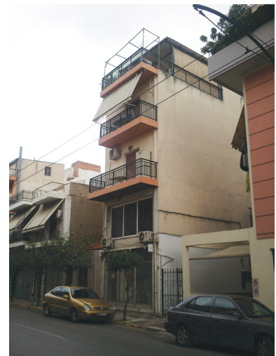
41, 42 Επιμήκη κτίρια ως απόρροια του συνεχούς καταμερισμού της γης σε οικόπεδα με στενό πρόσωπο και μεγάλο βάθος καθ' όλη τη διάρκεια της πολεοποίησης διαμορφώνοντας μία πολύ χαρακτηριστική τυπολογία “μακρόστενων” κτισμάτων και διαμερισμάτων. Επάνω , Αρόη, Πάτρα· κάτω , Νίκαια, Αθήνα.
