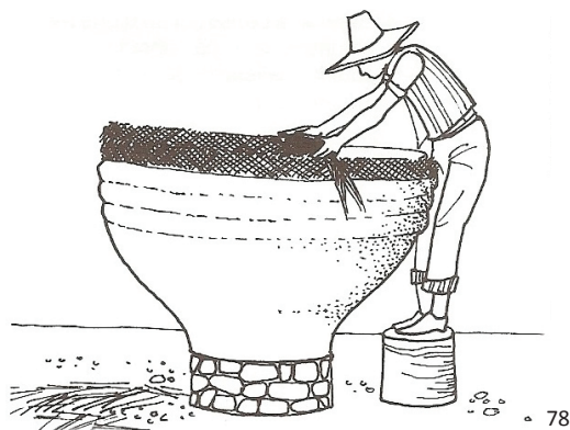
εικ.78: Σκίσο κατασκευής από φυτικές ίνες που τοποθετούνται σε σπείρες και καλύπτονται από πηλό εικ.79: Σιταποθήκη στο Τόγκο
