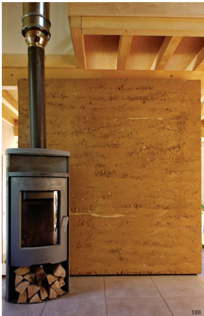
εικ.186: Κατοικία στο Corbel της Γαλλίας εικ.187: Εφαρμογή εκτοξευόμενου πηλοκονιάματος στην επιφάνεια των τοίχων από αχυρόμπαλες εικ.188: Τοίχος από rammed earth τοποθετημένος δίπλα σε ξυλόσομπα για αποθήκευση της θερμότητας
