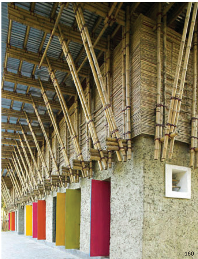
εικ.160: Αποψη του σχολείου, όπου φαίνεται η ισόγεια κατασκευή από χώμα και η κατασκευή του ορόφου από μπαμπού εικ.161: Εφαρμογή της τεχνικής “Wellerbau” εικ.162: Ανάμιξη μίγματος πηλού με τη βοήθεια ζώων κατά τη διάρκεια κατασκευής του σχολείου
