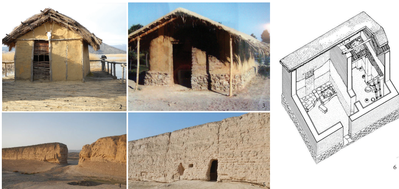
εικ.2: Πασσαλόπηκτη κατοικία από καλάμια και πηλό από την αναπαράσταση του προϊστορικού οικισμού στο Δισπηλιό του Ν. Καστοριάς εικ.3: Αναπαράσταση νεολιθικής κατοικίας από ωμόπλινθους (Σέσκλο Β') εικ.4,5: Τμήμα του Σινικού Τείχους ανατολικά της περιοχής Shandan κατασκευασμένο από rammed earth εικ.6: Σχεδιαστική αναπαράσταση νεολιθικής κατοικίας από ωμόπλινθους (Σέσκλο Β')
