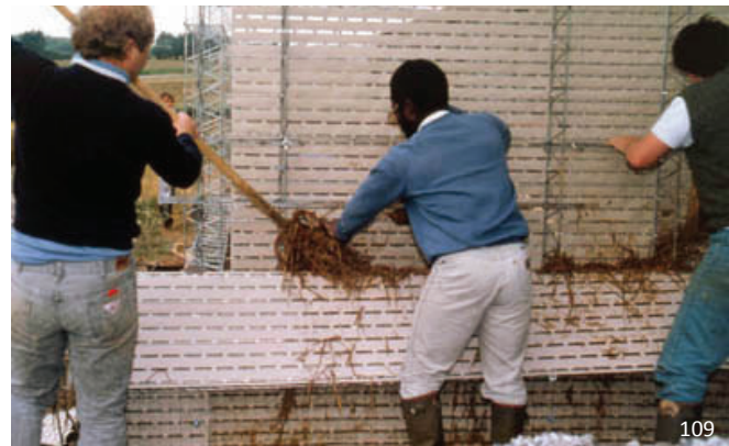
εικ.106: Σκίτσο προκατασκευασμένων δομικών στοιχείων που μπορούν να παραχθούν με straw clay εικ.107: Πλήρωση ξύλινου σκελετού με staw-clay εικ.108: Τούβλα από straw clay εικ.109: Κατασκευή τοίχου από staw clay με τη χρήση μεταλλικού σκελετού και ξυλοτύπου
