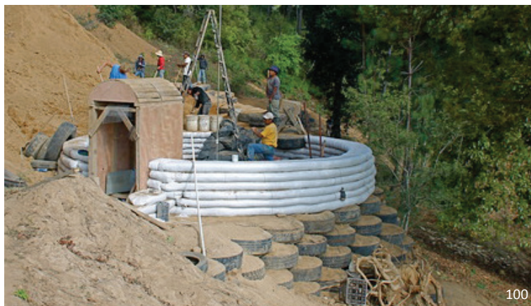
εικ.97: Κατασκευή κατοικίας από ρόδες γεμισμένες με χώμα στο Bhideva της Ρουμανίας εικ.98,99,100: Χρήση ανακυκλωμένων ροδών γεμισμένων με χώμα στην κατασκευή σχολείου στη Γουατεμάλα (2008)
