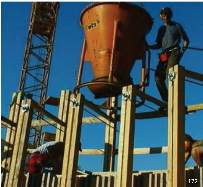
εικ.172,173: Κατασκευή τοίχου από rammed earth
