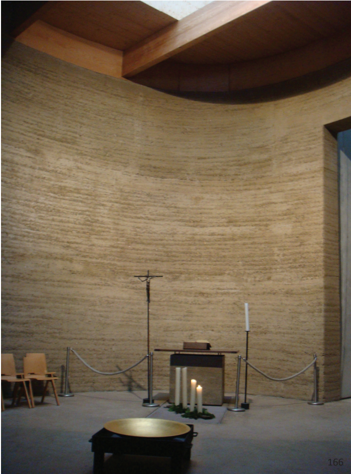
εικ.165 (αριστερά): Το Παρεκκλήσι της Συμφιλίωσης εικ.166: Εσωτερικός χώρος από το Παρεκκλήσι της Συμφιλίωσης με τοίχους και την Αγία Τράπεζα διαμορφωμένους από rammed earth εικ.167: Σκίτσα κάτοψης και προοπτικό της εκκλησίας
