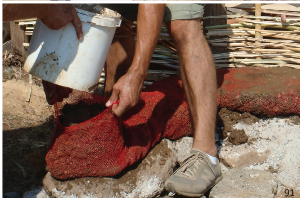
εικ.89,90: Κατασκευή από “superadobe”, Nader Khalili, California, ΗΠΑ εικ.91: Γέμισμα σωλήνα αραϊκής ύφανσης με χώμα που στη συνέχεια συμπιέζεται δημιουργώντας ένα συμπαγή και σταθερό τείχος ( εικ.92 )
