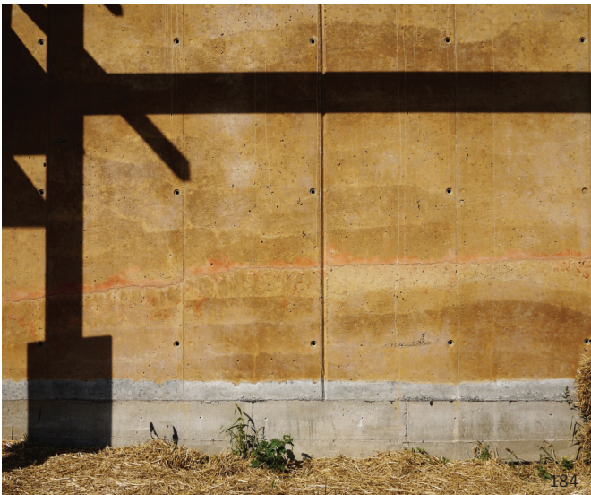
εικ.182: Εξωτερική άποψη του κτιρίου στο Sassenage εικ.183: Πλήρωση ξύλινου σκελετού από αχυρόματα εικ.184,185: Νότιος τοίχος από χύμα
