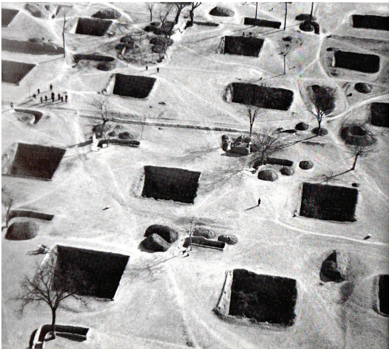
εικ.27: Υπόγειες κατοικίες στην περιοχή Tungkwan (Hohnan) της Κίνας οργανωμένες γύρω από αίθρια, επιφάνειας περίπου όσο ένα γήπεδο του τένις και ύψους 7-9m, λαξευμένα κατακόρυφα στο έδαφος. Κλίμακες σχήματος L οδηγούν υπόγεια από το επίπεδο του εδάφους στο υποβαθμισμένο επίπεδο του αιθρίου και των κατοικιών.
