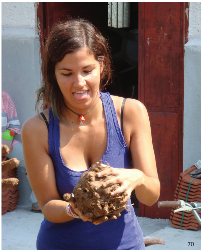
εικ.70: Σχηματίζοντας μπάλες από χώμα για κατασκευή από cob, σε εισαγωγικό εργαστήριο για τη φυσική δόμηση διοργανωμένο από την ομάδα "cob"
