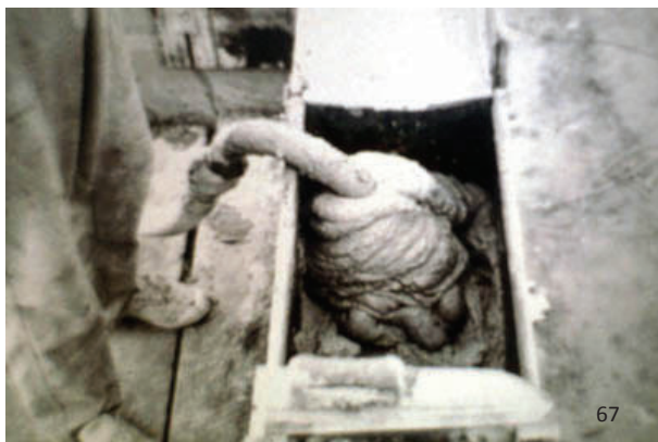
εικ.66,67,68: Κατασκευή δόμων κατευθείαν πάνω στον τοίχο με ρευστή γη μέσα σε καλούπια - ξυλότυπους
