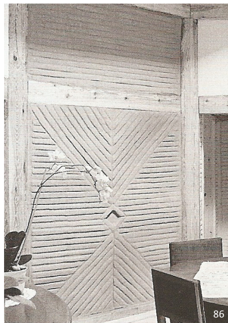
εικ.83: Μια κοινή λύση θερμομόνωσης τοίχων με δομικά στοιχεία από εξωθημένο πηλό εικ.84,85: Παραγωγή και μεταφορά, αντίστοιχα, εξωθούμενων ρολών για τη κατασκευή κατοικίας στο Kassel (1984) εικ.86: Τοίχος κατασκευασμένος με την τεχνική “stranglehm” σε κατοικία στην Uchte της Γερμανίας (1986)
