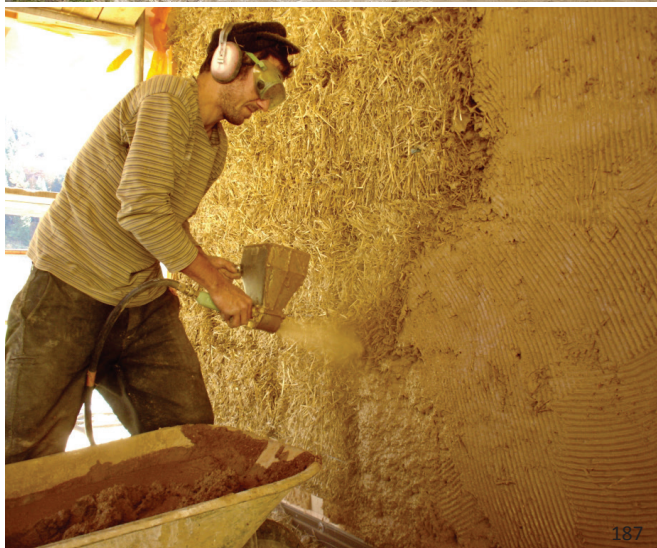
εικ.186: Κατοικία στο Corbel της Γαλλίας εικ.187: Εφαρμογή εκτοξευόμενου πηλοκονιάματος στην επιφάνεια των τοίχων από αχυρόμπαλες εικ.188: Τοίχος από rammed earth τοποθετημένος δίπλα σε ξυλόσομπα για αποθήκευση της θερμότητας
