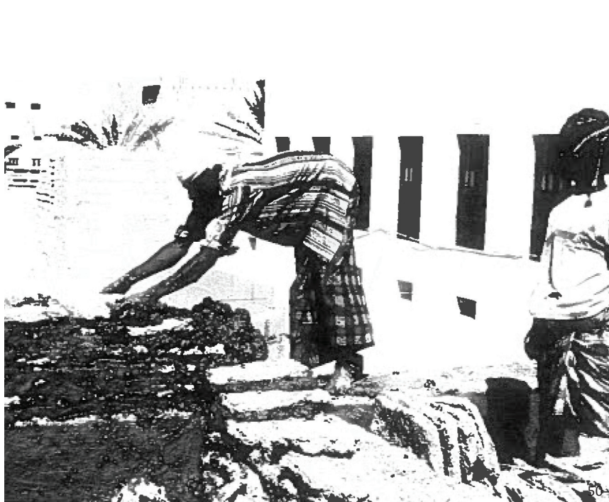
εικ.49: Η πυκνοδομημένη πόλη Shibam από ψηλά εικ.50: Στρώσιμο πλίνθων στην κατασκευή, με χρήση πηλοκονιάματος που διαμορφώνει αρμούς ύψους ίσου με το ύψος των πλίνθων. Παλαιότερα οι αρμοί κατασκευάζονταν πιο στενοί. (Υεμένη)
