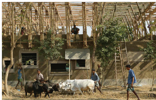
εικ.160: Αποψη του σχολείου, όπου φαίνεται η ισόγεια κατασκευή από χώμα και η κατασκευή του ορόφου από μπαμπού εικ.161: Εφαρμογή της τεχνικής “Wellerbau” εικ.162: Ανάμιξη μίγματος πηλού με τη βοήθεια ζώων κατά τη διάρκεια κατασκευής του σχολείου
