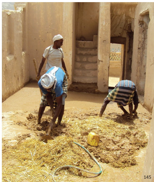
εικ.144: Εργασίες αποκατάστασης των εξωτερικών επιφανειών των τοίχων εικ.145: Κατασκευή δώματος από μίγμα πηλού και άχυρου (Dar Dawil)
