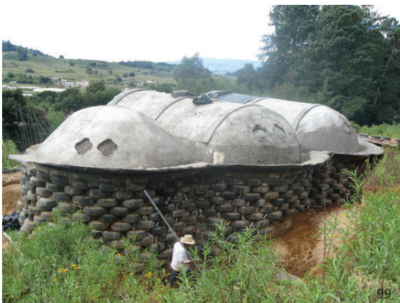
εικ.97: Κατασκευή κατοικίας από ρόδες γεμισμένες με χώμα στο Bhideva της Ρουμανίας εικ.98,99,100: Χρήση ανακυκλωμένων ροδών γεμισμένων με χώμα στην κατασκευή σχολείου στη Γουατεμάλα (2008)
