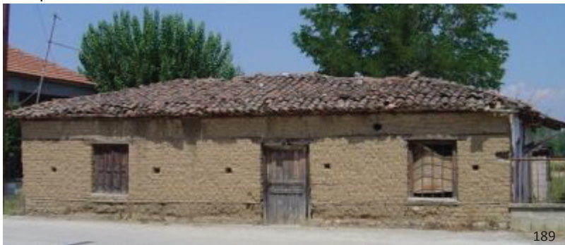
εικ.189,190: Πλινθόκτιστα κτίρια στο Ν.Φθιώτιδας και το Ν. Τρικάλων αντίστοιχα
