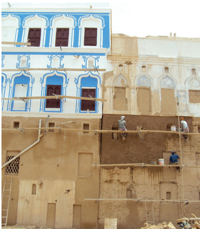
εικ.144: Εργασίες αποκατάστασης των εξωτερικών επιφανειών των τοίχων εικ.145: Κατασκευή δώματος από μίγμα πηλού και άχυρου (Dar Dawil)
