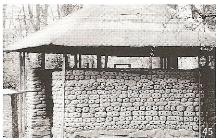
εικ.44,46: Σκίτσο αναπαράστασης της κατασκευής με την τεχνική Dünne εικ.45: Κτίριο με ανεπίχριστη τοιχοποιία στο Dünne της Γερμανίας
