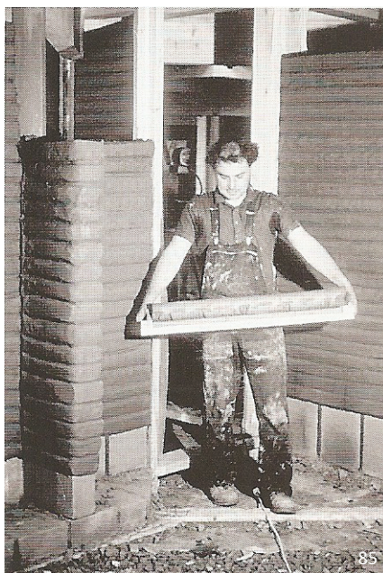
εικ.83: Μια κοινή λύση θερμομόνωσης τοίχων με δομικά στοιχεία από εξωθημένο πηλό εικ.84,85: Παραγωγή και μεταφορά, αντίστοιχα, εξωθούμενων ρολών για τη κατασκευή κατοικίας στο Kassel (1984) εικ.86: Τοίχος κατασκευασμένος με την τεχνική “stranglehm” σε κατοικία στην Uchte της Γερμανίας (1986)
