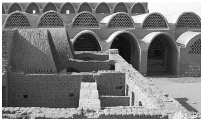
εικ.7: Αποθήκες του Ραμσείου στεγασμένες με κυλινδρικούς θόλους εικ.8: Σχέδιαστική αναπαράσταση κατασκευής κυλινδρικών θόλων με ωμές πλίνθους στην αρχαία Αίγυπτο εικ.9: Κατασκευή θόλων για εκπαίδευση τεχνητών με πρωτοβουλία του Hassan Fathy εικ.10: Θολωτές κατασκευές από ωμόπλινθους στο χωριό New Baris σχεδιασμένο από τον Hassan Fathy
