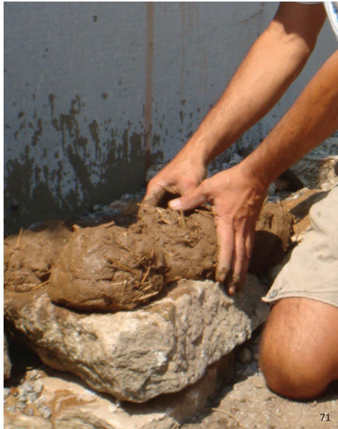
εικ.70: Σχηματίζοντας μπάλες από χώμα για κατασκευή από cob, σε εισαγωγικό εργαστήριο για τη φυσική δόμηση διοργανωμένο από την ομάδα "cob"
