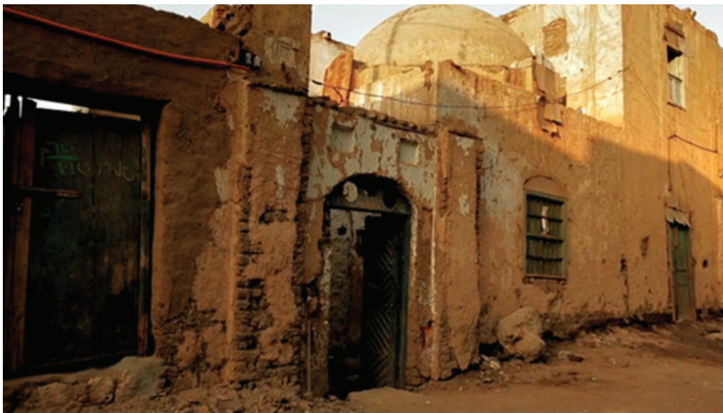
εικ.128: Διάβρωση των τοίχων από τη μακροχρόνια επίδραση του καιρού, λόγω έλλειψης συντήρησης (New Gourna, Fathy)
