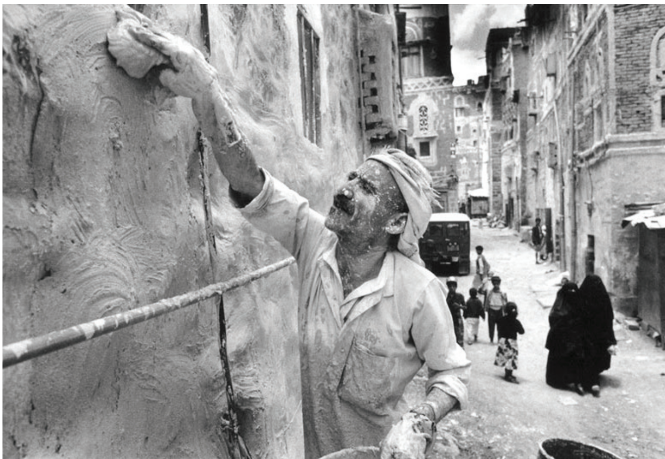
εικ.130: Εφαρμογή ασβεστοχρώματος στην εξωτερική επιφάνεια των τοίχων στην Υεμένη
