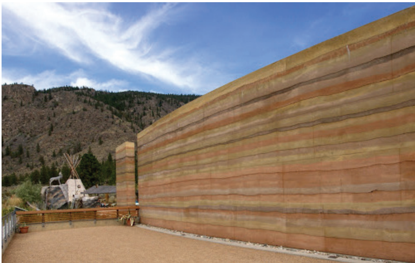
εικ.62: Οψη του Nk'Mip Desert Interpretive Centre στο Osoyoos του Καναδά, διαμορφωμένη από τοίχο rammed earth ύψους 6m με διακριτές ζώνες συμπίεσης, κάνοντας χρήση χώματος διαφορετικών αποχρώσεων.
