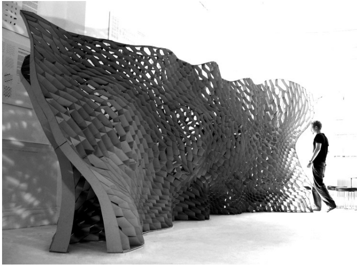
Εικόνα7 → Κατασκευή του ψηφιακού μοντέλου με CAM μεθόδους, Όλα τα στοιχεία των κυψελών κόπηκαν και συναρμολογήθηκαν επί τόπου.
