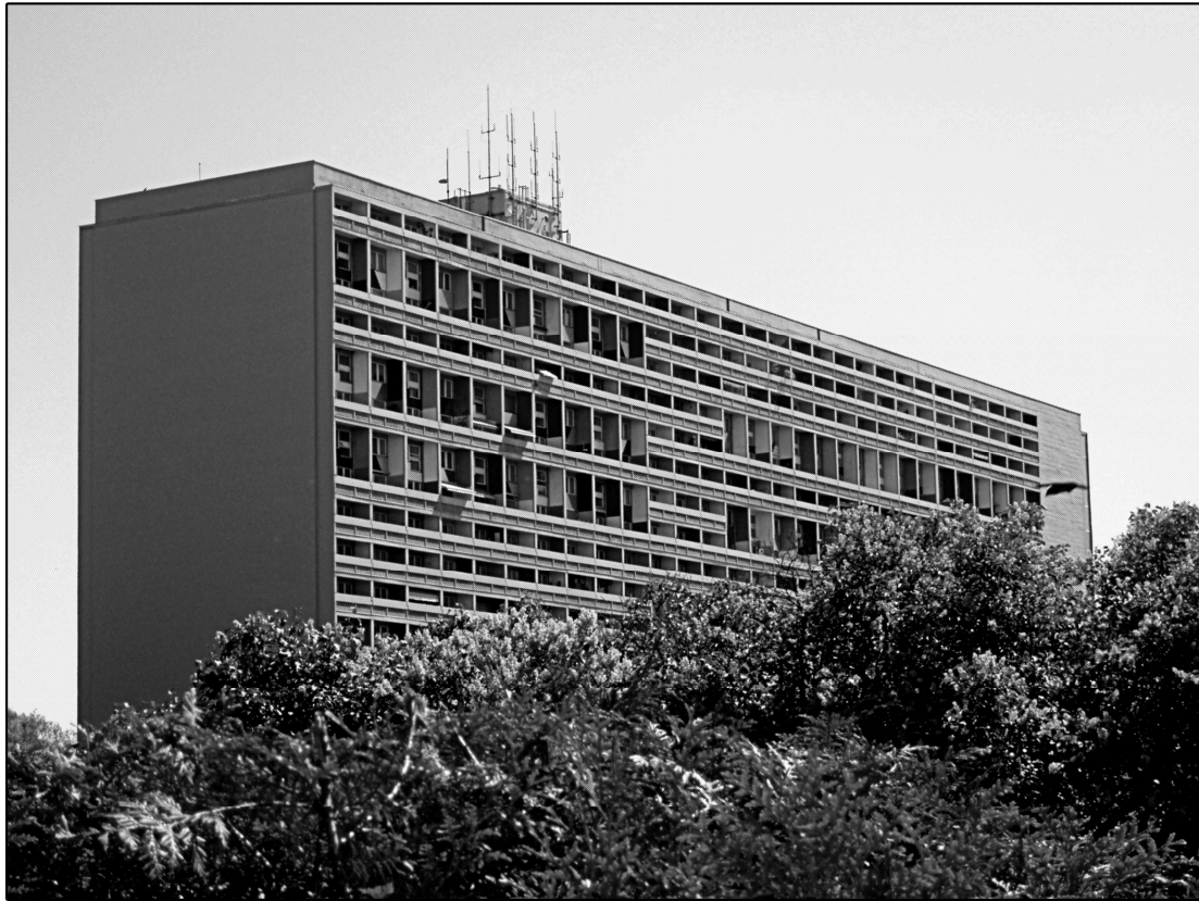
Unité d'Habitation, Le Corbusier, Βερολίνο.
