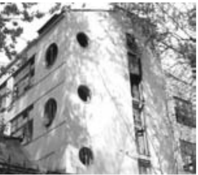
Εικόνα.156: Το μοναδικό από παράδειγμα αρχιτεκτονικής του Lissitzky, τυπογραφείο OGONYOK, 1928, η κυβέρνηση δεν το ενέκρινε ως μέρος της πολιτιστικής της κληρονομιάς και τον Οκτώβρη του 2008 το κτίριο καταστράφηκε από πυρκαγιά.
