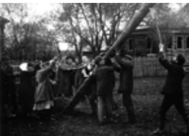
Εικόνα.12: Εγκατάσταση των θέσεων για τις γραμμές μεταφοράς ηλεκτρικής ενέργειας σε ένα από τα ρωσικά χωριά. 1925
