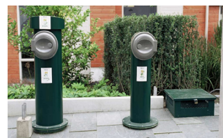
Εικ.36: Δοχεία απόρριψης απορριμμάτων που συνδέονται με υπόγειο δίκτυο αγωγών
