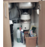
Εικ.35: Ειδικοί μύλοι άλεσης οργανικών υπολειμμάτων των τροφών
