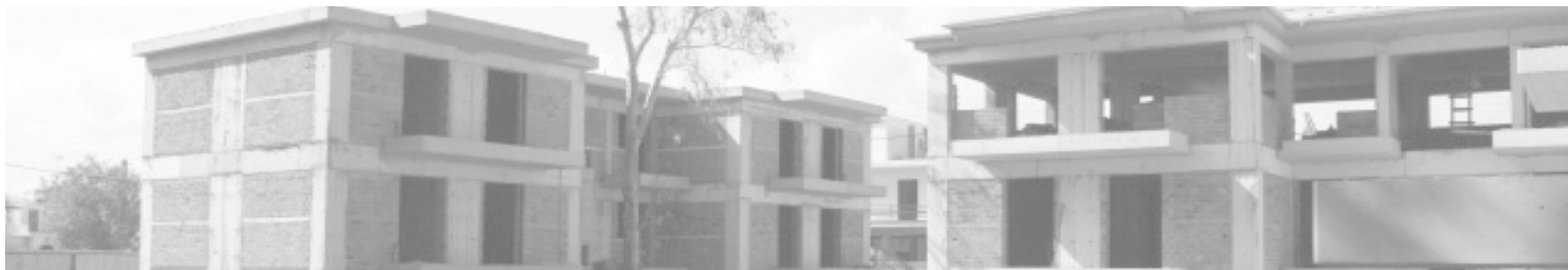
Βιοκλιματικός οικισμός Ελευσίνας , Αττική
