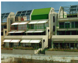
Εικ.20: Κλείσιμο χώρων που προβλέπονταν για την κάλυψη ενεργειακών αναγκών των κτιρίων για χρήση τους ως βιώσιμους χώρους
