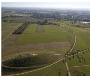
Εικ.30: Διαμόρφωση τοπίου με τα χώματα εκσκαφής
