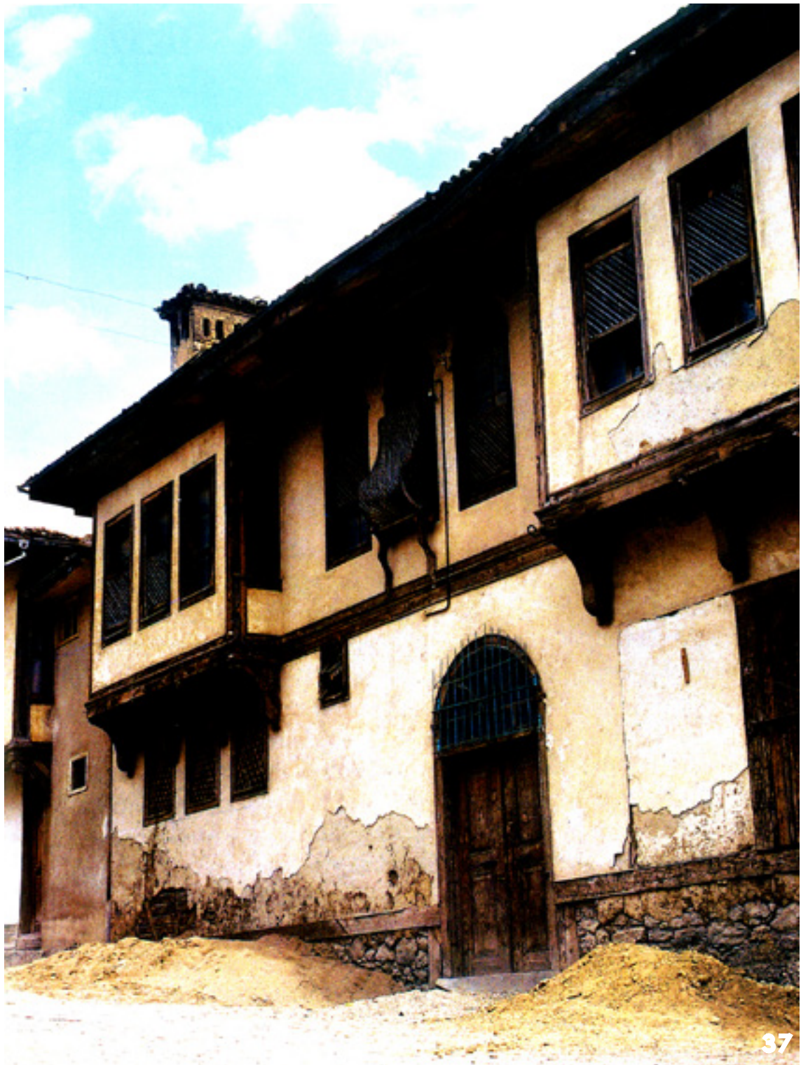
Εικόνα παραδοσιακής κατοικίας του Βοσπόρου, απεικόνιση του αρχιτεκτονικού στοιχείου του παζουριού στο μέσο των παραθύρων του πρώτου ορόφου
