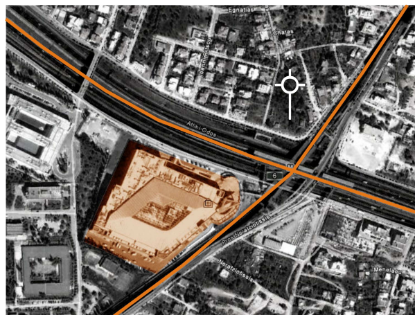
Εικ. 15. Το The Mall Athens και η κομβική του θέση στη διασταύρωση τριών μεταφορικών συστημάτων, της Αττικής οδού, του προαστιακού σιδηρόδρομου και του ΗΣΑΠ.
