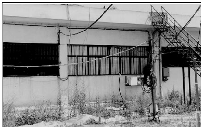
Σχήμα 2: Η νότια όψη του Εργαστηρίου Κατασκευών του Γ.Π.Α.
